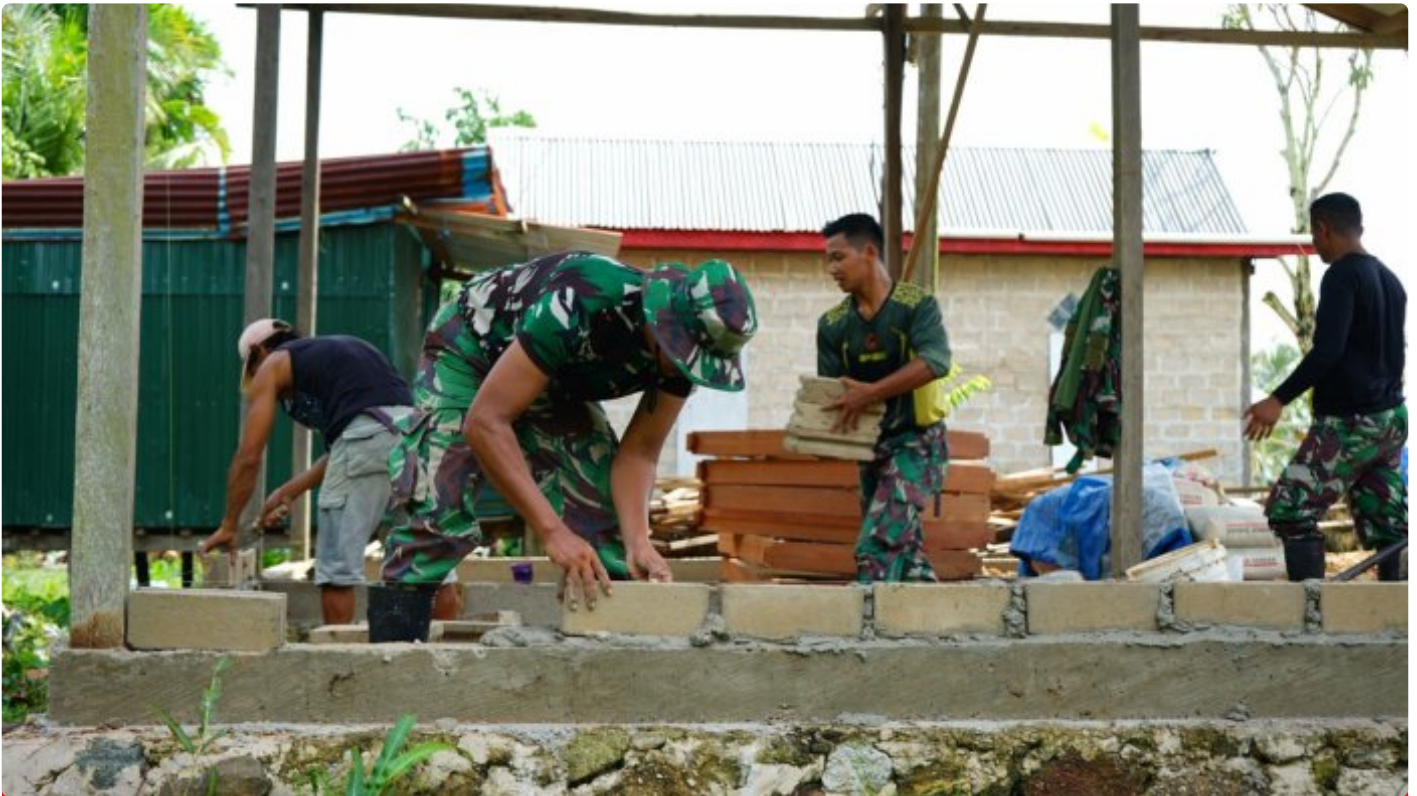
Rehab Rumah Warga, Satgas TMMD 116 Kodim 0907/Trk Selalu Mengedepankan Kualitas
